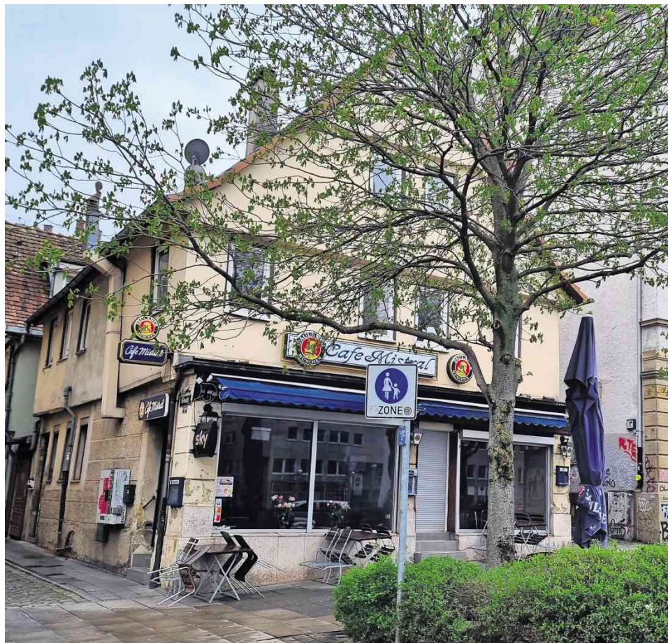
Die aktuelle Ansicht auf das historische Gebäude Hauptstätter Straße 49
